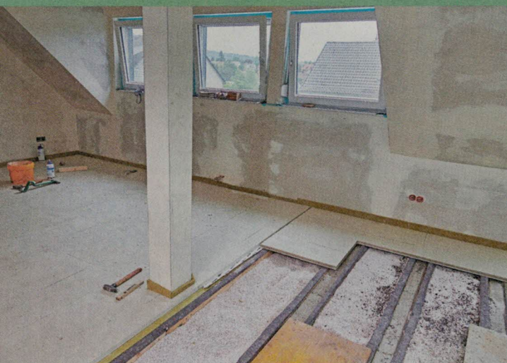
22 In der Folge legt man dann wie gehabt stoßverleimt die wandnahe erste Plattenreihe durch und beginnt die zweite mit dem Reststück der Vorreihe. Auch dieses erste Stück wird mit breitem Fugenabstand zur linken Teilfläche verlegt.
