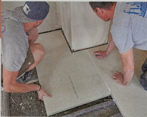
16 Das betroffene Element wird dann in die Nut der Vorplatte geschoben und sitzt zusätzlich satt auf den Gipsbatzen auf. Die Ausklinkung am Schonstein wird zuvor genau gemessen.
