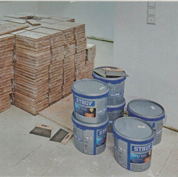
33 Am besten schon frühzeitig die Parkettstäbe gestapelt im gut temperierten Verlegeraum lagern.
