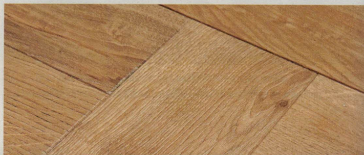
50 Am Ende der Verklebung hat der Bauherr noch einmal selbst geölt und den Holzboden zusätzlich „angefeuert“.
