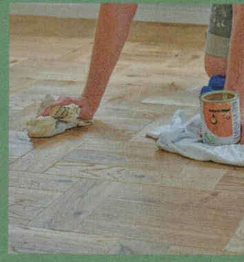
50 Am Ende der Verklebung hat der Bauherr noch einmal selbst geölt und den Holzboden zusätzlich „angefeuert“.
