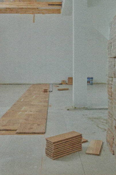
42 Die zwei ersten Reihen sind verklebt, nun arbeitet man in die Gegenrichtung.
