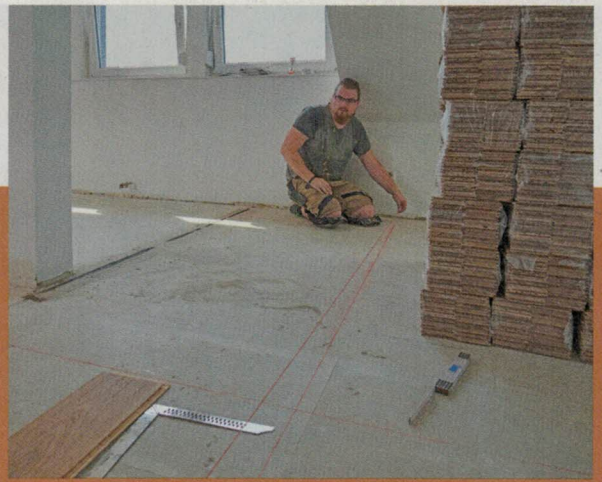
34 Um die richtige Ausrichtung der Stabparkettreihen zu erlangen, haben sich die Verleger an der Wohnungstür orientiert und von dort aus mittig per Schnurschlag eine 90-Grad-Linie am Boden markiert.
