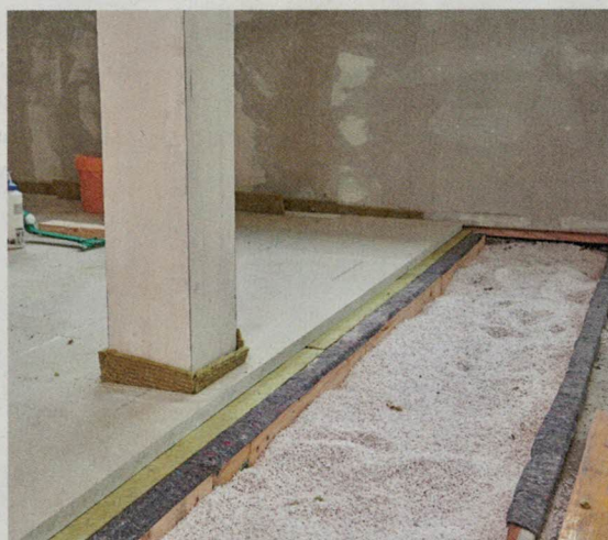
19 Hier sind wir angelangt, wo eine neue Balkenlage beginnt. An der gerade abgeschnittenen Plattenkante müssen nun die nächsten Platten um 90 Grad gedreht verlegt werden.
