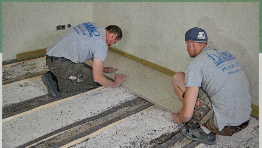
10 Die erste Platte wird also ganz ins linke Raumeck geschoben, die Nuten zeigen dann nach vorne und rechts. Eine Platte wiegt knapp 40 kg, sodass es zu zweit leichter ist, die Elemente zu verlegen. Darauf achten, dass keine Körner aus der Schüttung auf die Textilstreifen kommen.
