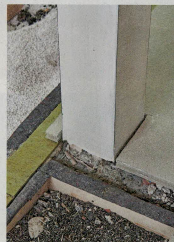
18 ... zu verlegen, mit entsprechendem Fugenabstand und schmalen Reststeg zur nächsten Platte.
