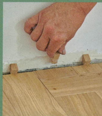
49 Und natürlich ist wie bei anderen Belagsarten auch der Wandabstand einzuhalten und vorläufig zu sichern.
