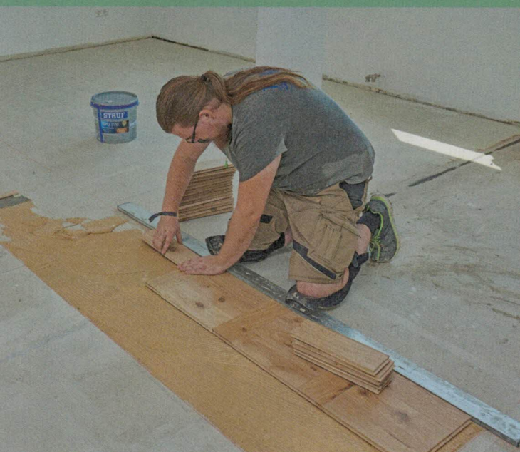
38 Drei Stäbe bilden dann eine Längseinheit, dann bildet ein linker Stab einen Querriegel, dann folgen wieder drei Längsstäbe als nächstes Teilfeld etc.
