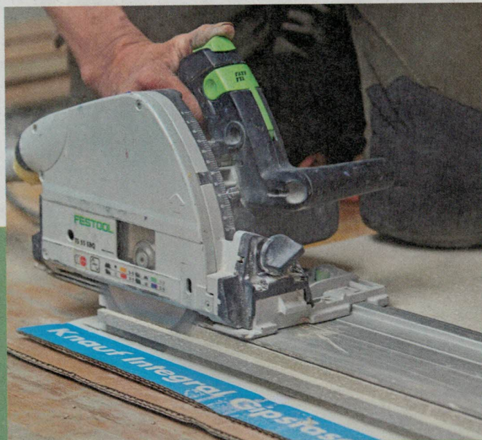
8 Damit kann die Verlegung der tragenden Systemelemente beginnen. An den ersten Platten werden wandseitig die Federn abgesägt. Mit der Handkreissäge und einer Führungsschiene geht das schnell. Staubabsaugung nicht vergessen!
