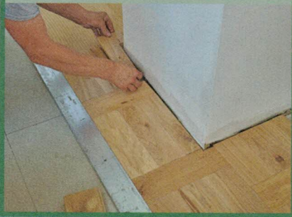
45 ... geht es gleich weiter mit der Parallelreihe, die wieder mit einem mittig angesetzten Querholz beginnt und so den Versatz vorgibt.
