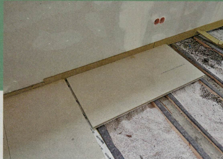
21 Auf einem Gleitpapierstreifen (hier weiß), der nach unten hin entkoppelt, wird die erste Platte mit abgesägter Feder so aufgelegt, dass etwa ein zwei Zentimeter breiter Spalt bleibt (zum Beispiel als Maß ein Richtscheit einlegen).
