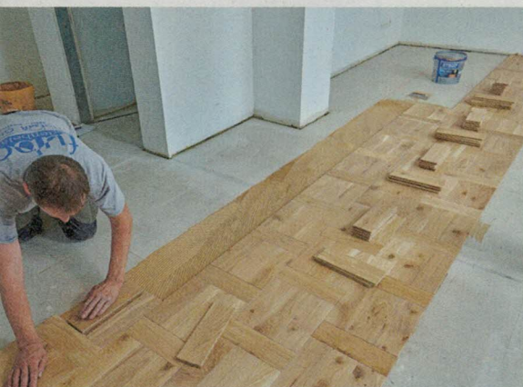
47 Und so langsam entwickelt der Holzboden seine eigene Dynamik. Das Flechtmuster wird schon deutlich erkennbar.
