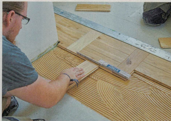
45 ... geht es gleich weiter mit der Parallelreihe, die wieder mit einem mittig angesetzten Querholz beginnt und so den Versatz vorgibt.
