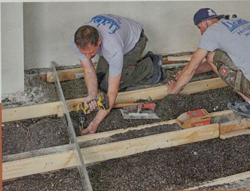
4 Je nach Balkenabständen flanscht man eine Bohle mit \geq 40 mm an einer Seite an oder wie hier jeweils rechts und links der Deckenbalken eine. Je nach Schiefelage der Balken stehen dann die Bretter mal mehr, mal weniger über. Wichtig: Auch immer quer zur Balkenrichtung die neue Höhe überprüfen!
