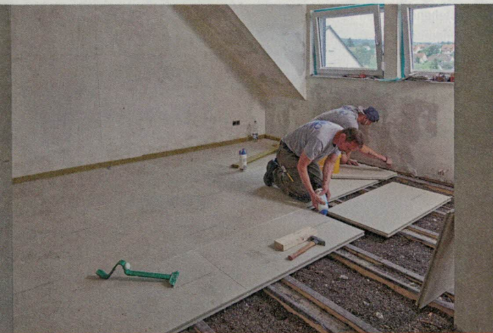
14 Hier in der ersten größeren Fläche erkennt man gut, dass zum einen die Plattenreihen mindestens um 30 Zentimeter versetzt angeordnet sind, zum anderen, dass fließende Stöße möglich sind, also Plattenstöße ohne direkte Unterfangung.
