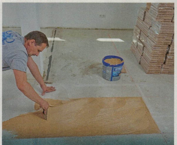
36 Das geschmeidige Material lässt sich sehr gut mit der Zahnkelle verteilen und aufkämmen. Dabei immer in Teilflächen vorgehen.
