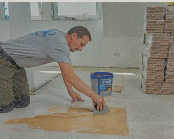
35 Nach einer weiteren rechtwinklig dazu angelegten Orientierungslinie wurde das erste Doppelreihenfeld markiert und hier innerhalb der Kleber aufgetragen.
