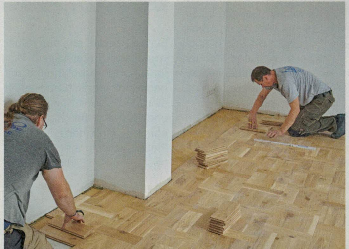
43 Dazu wird auch wieder eine Teilstrecke mit Klebstoff versehen. Hier ist gleich auch ein Wandsegment im Weg.
