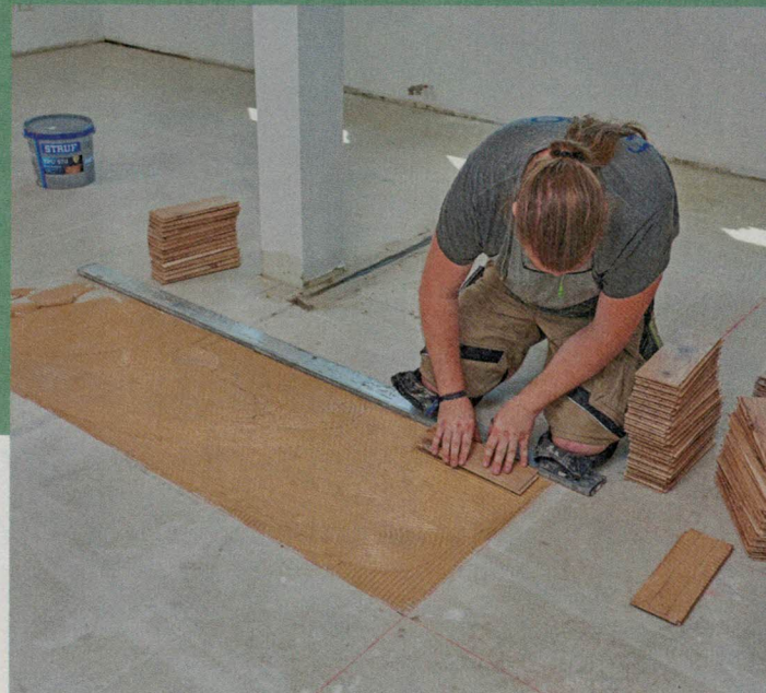
37 Mit Hilfe eines Richtscheits, das genau an der Markierungslinie angelegt wird, beginnt die Verklebung. Die Stäbe in Längsrichtung sind hier die rechten Stäbe.
