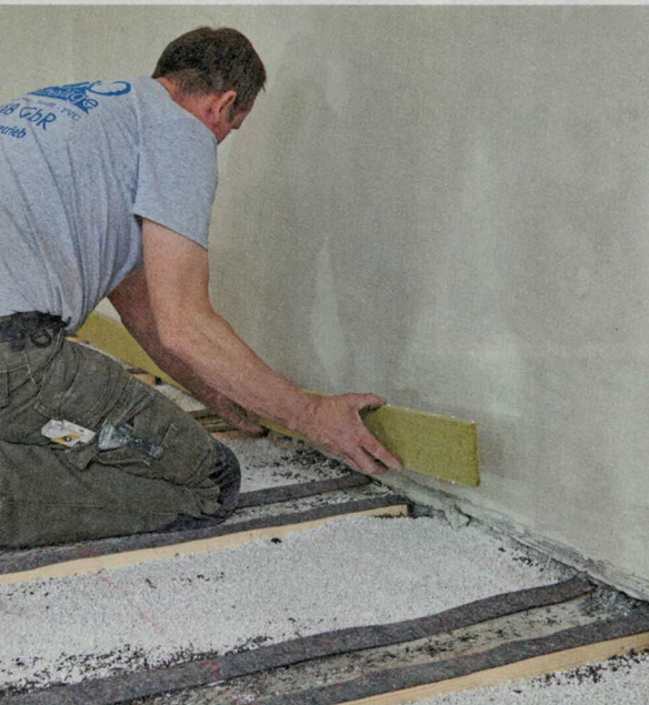
9 Mit frei aufgestellten Mineralwolle-Randdämmstreifen sorgt man noch für einen 10 mm breiten Wandabstand. Die Estrichplatten können dann daran direkt anstoßen.
