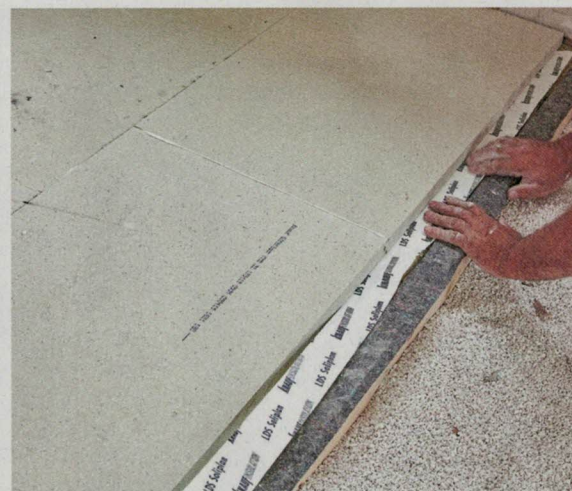
20 Wichtig dabei, dass auch hier ein formschlüssiger und dauerhaft fester Anschluss hergestellt wird, auch wenn keine Nut-und-Feder-Verbindung möglich ist.
