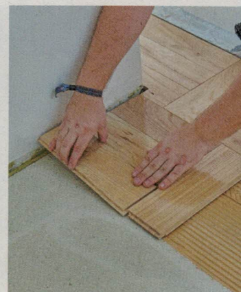
46 Die Reststücke werden eingemessen und mit Wandfuge verklebt.
