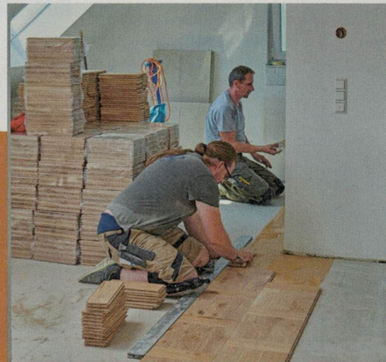
44 Das Richtscheit dient wieder als Hilfsanschlag für die Einhaltung der Außenlinie. Nach der Wand ...
